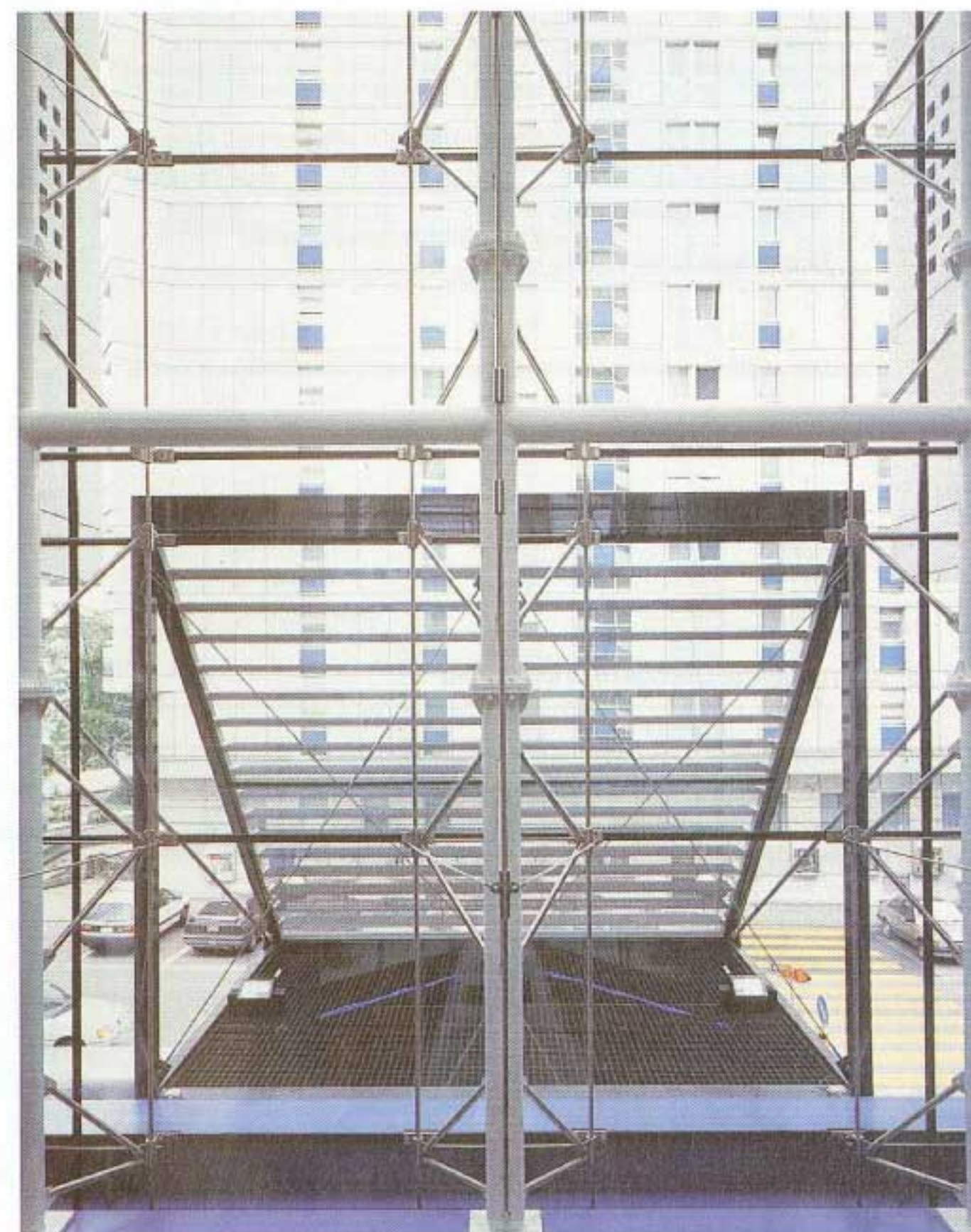
Marquise de l'entrée en acier noir, contrastant avec la verrière en acier blanc et la structure porteuse en acier bleu
