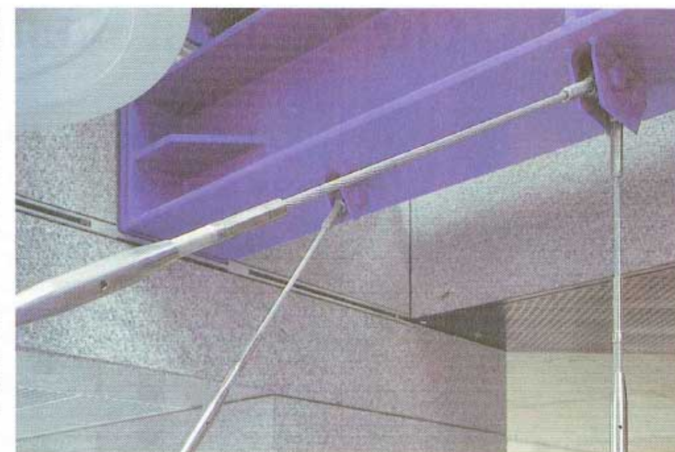
Câbles de suspension de la passerelle, attache à la structure
