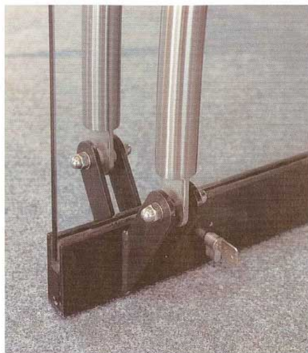
Poignée des portes des commerces, fixation au centre de la porte («tout ce que la main touche est en acier inox, le reste de la serrurerie est en acier noir»)
