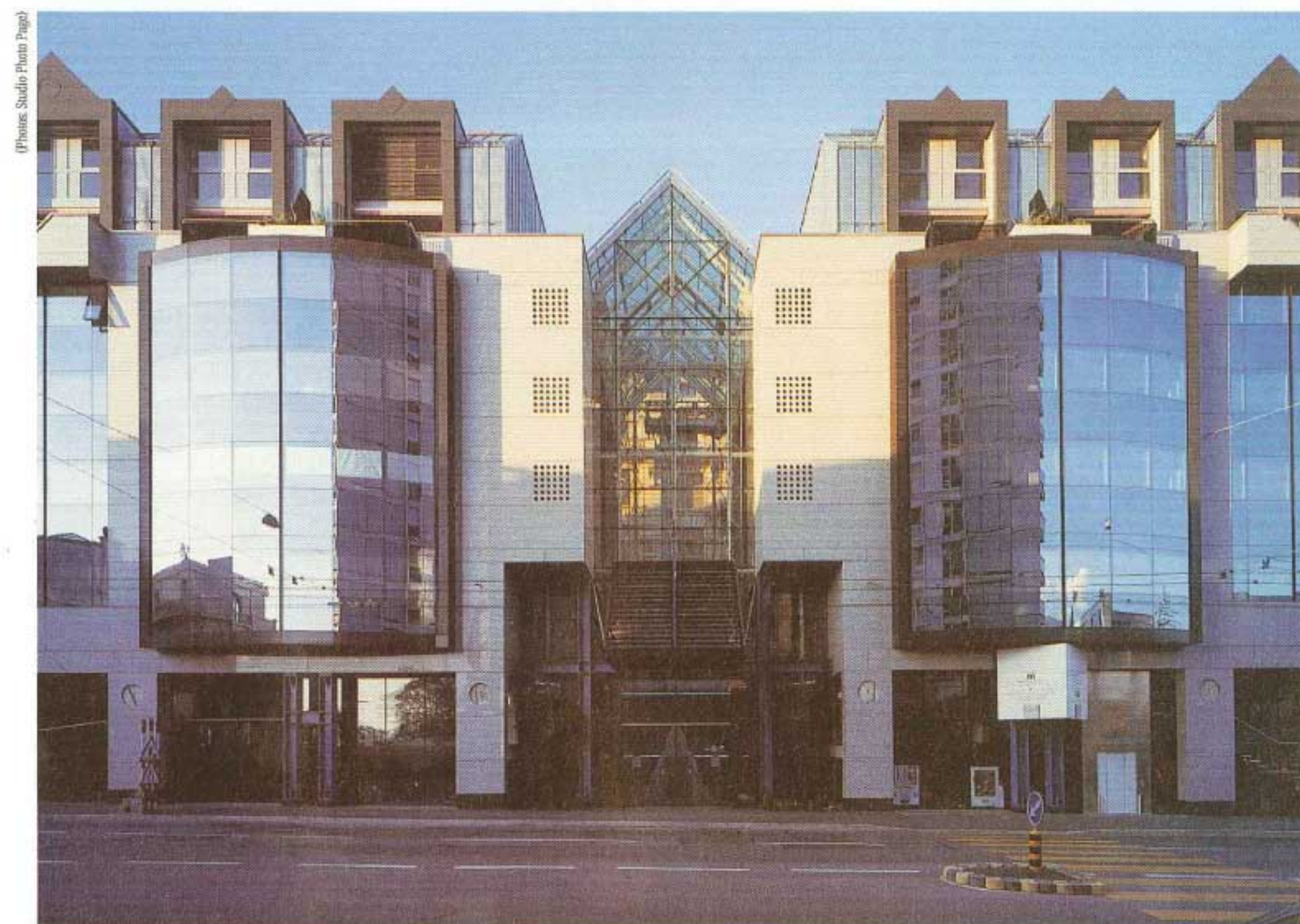
Cité-Centre. Entrée principale: contraste entre les deux volumes pleins (granit) et la verrière centrale (métal et verre), toiture en zinc-titane, double effet du verre (transparence de la verrière, effet-miroir des bow-windows)
