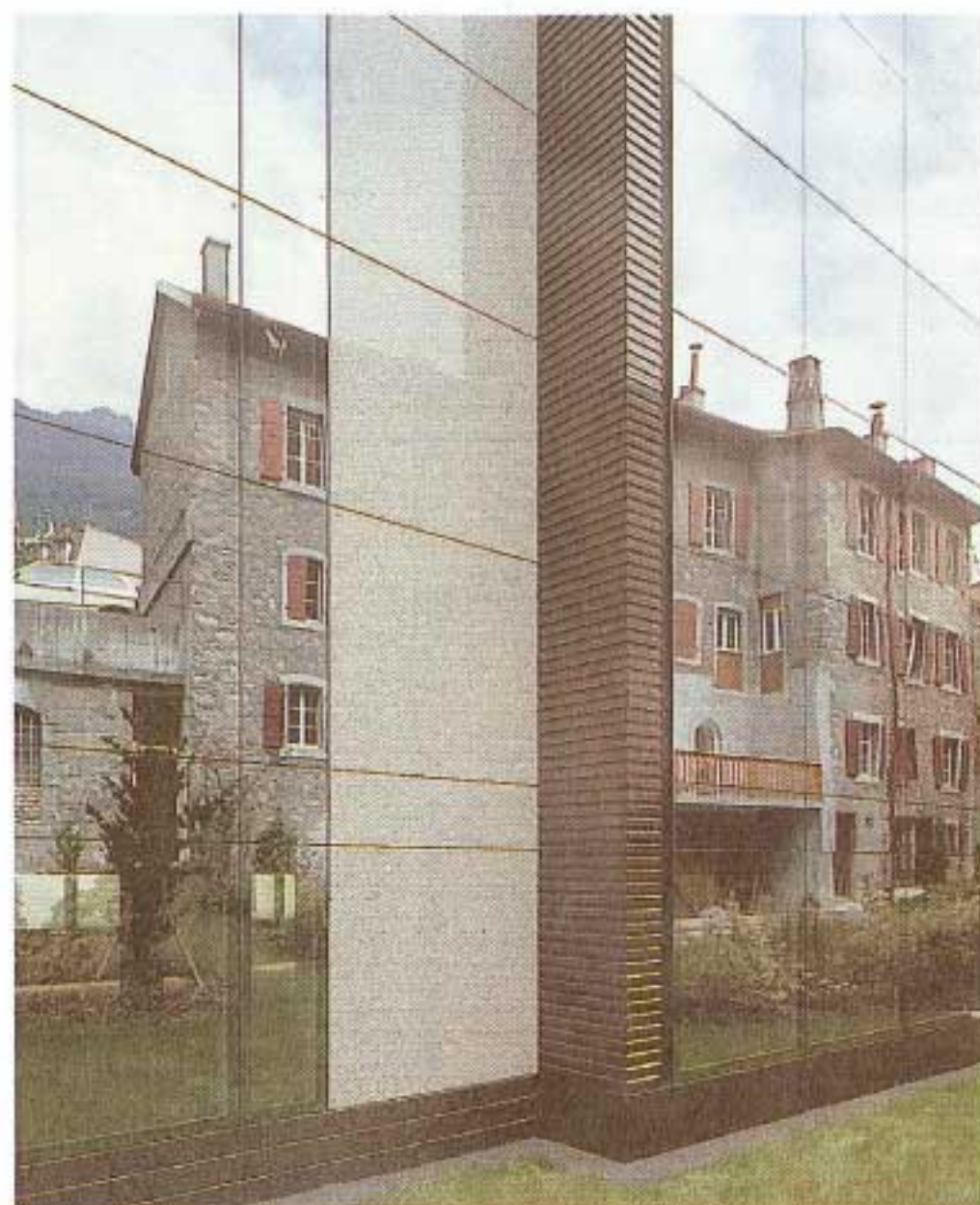
Reflets d'un immeuble en façade nord, promenade publique
